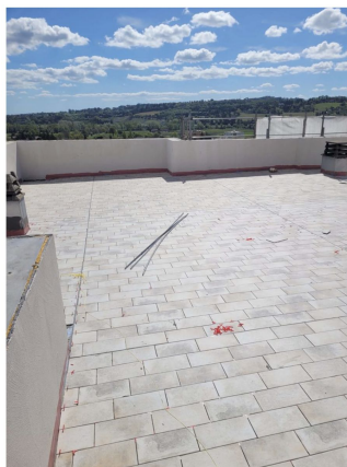
Progress Profiles / Pavimentazione posata
