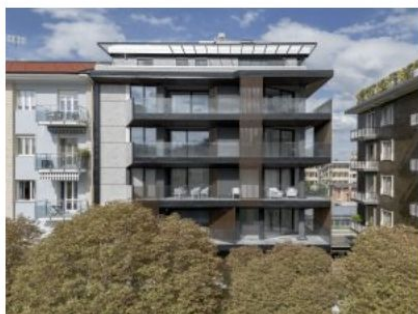
Il sistema a secco per esterni garantisce flessibilità di utilizzo ed elevata resistenza a umidità e ad agenti atmosferici, grazie alle speciali lastre in gesso fibrorinforzato e ai pannelli isolanti ad alte prestazioni (foto Saint-Gobain Italia)
