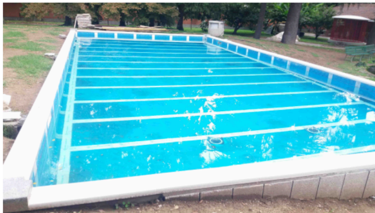
3. Prova di carico della vasca effettuato dopo 7 giorni.
