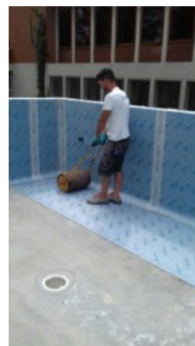
1. Posa di Profoil a parete e a pavimento con adesivo cementizio sul supporto e con Proband fix sulle flange degli skimmer e posa delle bandelle Proband 150 a parete e a pavimento con Proband Fix.
