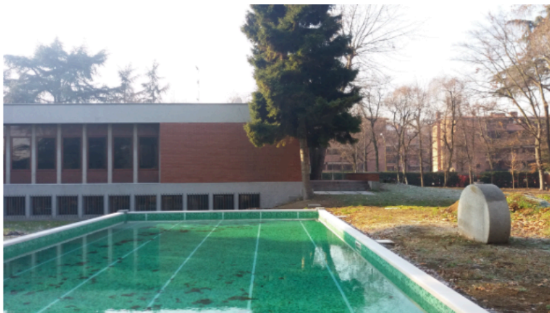
Realizzazione di una piscina nel giardino di una villa privata.
