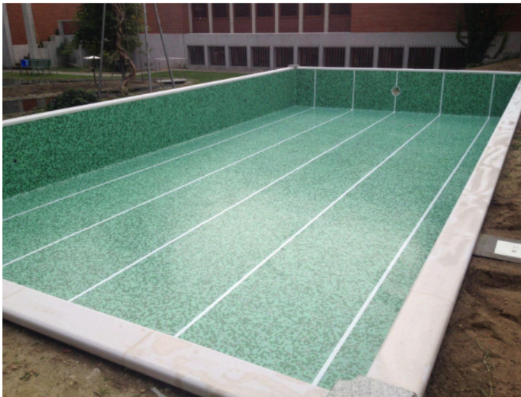
6. Posa del rivestimento ceramico ultimato.
