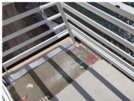
La membrana Prodeso sul massetto con adesivo classe C2TE e la protezione Prot Terrace Drain FDP bianco raccordato alla guaina Prodeso con Proband 150.
