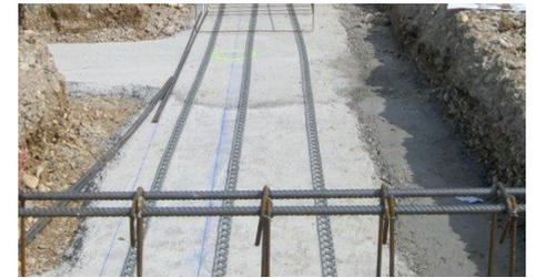
Distanziatore lineare estremamente robusto e resistente, unibile longitudinalmente con un semplice incastro per ottenere lunghezze variabili. La nuova forma permette di coniugare elevate performance tecniche alla ottimizzazione dei costi.
