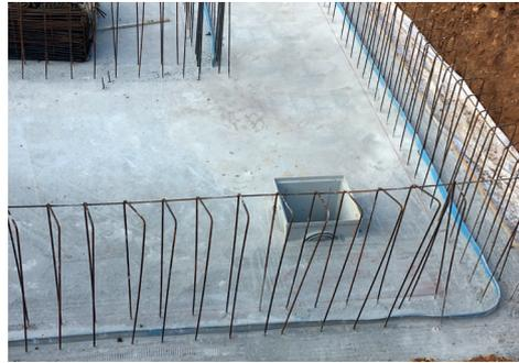
WATERSTOPS ПРОФИЛЬ С РАСШИРЕНИЕМ - синий пластифицированный
