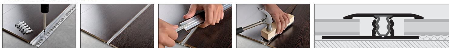
1. Fissare e/o incollare la base a pavimento. 2. Procedere alla posa del pavimento lasciando da 3 a 10 mm fra il pavimento e l'inserto. 3. Scegliere il profilo desiderato, se necessario tagliare TOP, PIN e BASE nella lunghezza desiderata, quindi inserire il PIN nel TOP nell'apposita sede a forma di 'coda di rondine', quindi posizionare il profilo sopra la sede ad incastro ad 'U' della base. 4. Con l'ausilio di una tavoletta martellare il TOP, fino al livello d'incastro desiderato.
