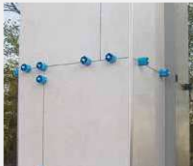
Girando il tirante si possono livellare spessori fino a 40mm con fuga da 8mm.
